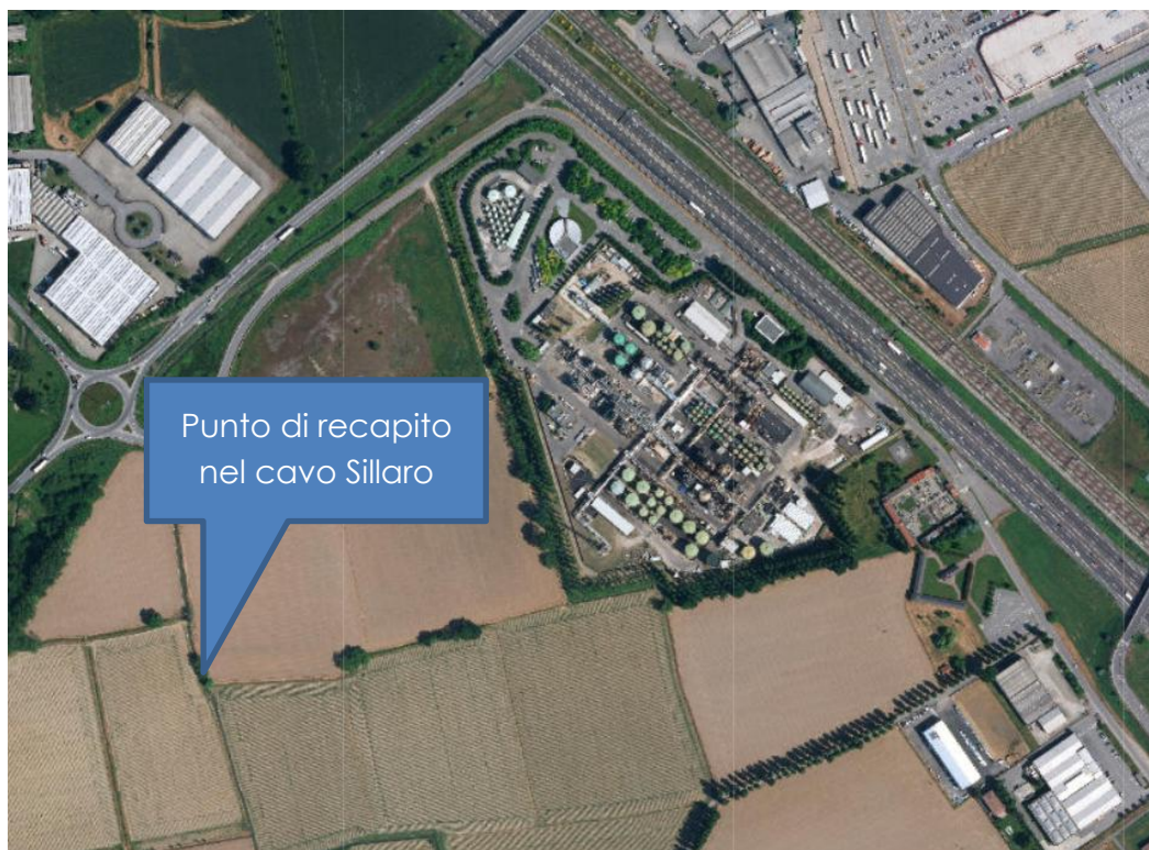
Punto di scarico nel cavo Sillaro
